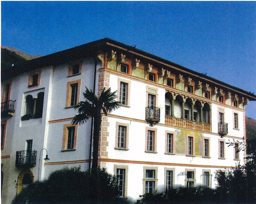
Palazzo Branca-Bacçalà dopo il restauro.
